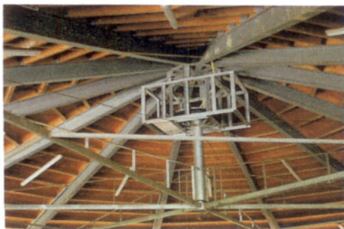
Antrieb einer Deckenfähranlage • • • • •
